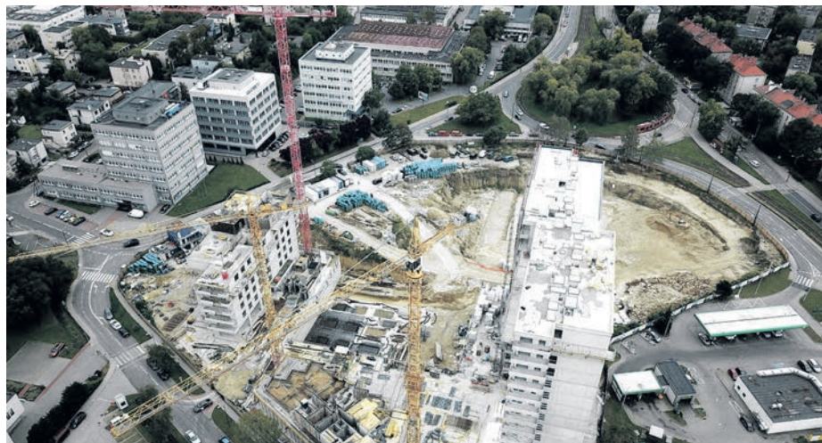
Budowa mieszkań przy pętli Słonecznej
