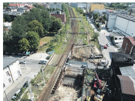
Przebudowa wiaduku przy ul. Lwowskiej
