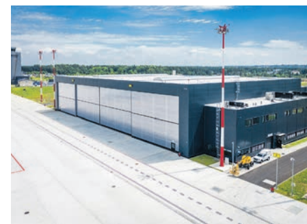
Nowy hangar w Pyrzowicach
