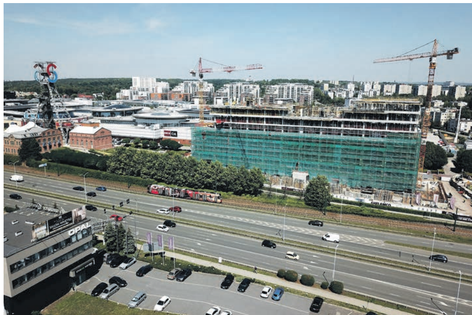
Biurowiec Craft w budowie
