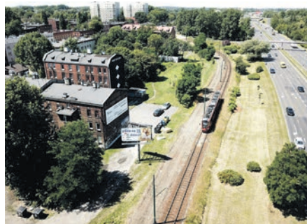
Modernizacja torowiska w Załężu
