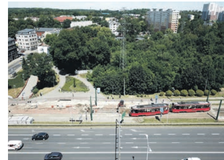
Modernizacja torowiska w Dębnie
