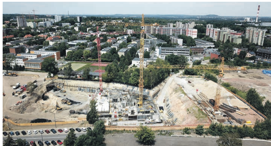
Realizacja inwestycji Atal Olimpijska
