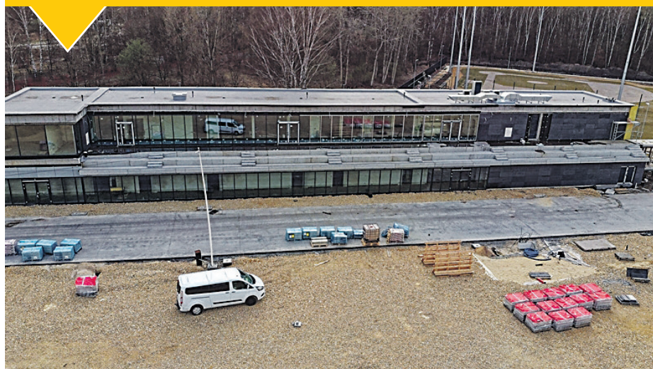
FOT. KATOWICKIE INWESTYCJE S.A.
