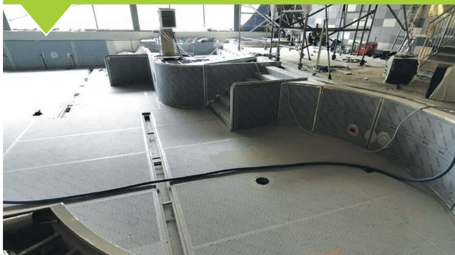
FOT. KATOWICKIE INWESTYCJE S.A.
