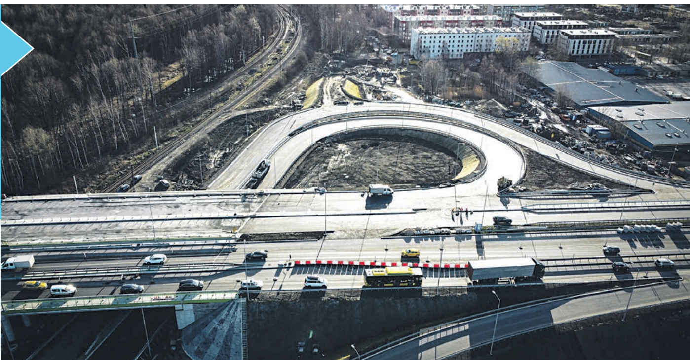
FOT. KATOWICKIE INWESTYCJE S.A.
