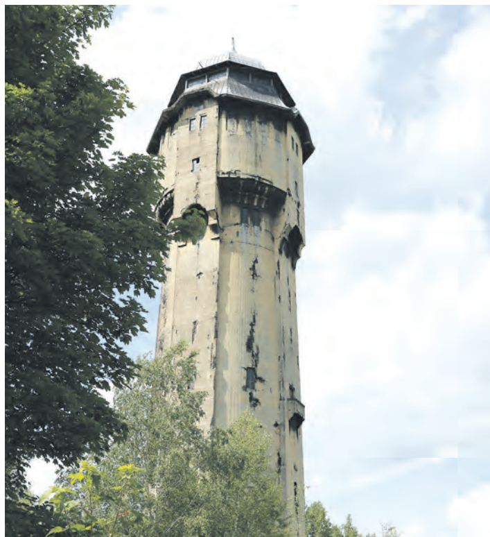
Wieża wodna przy ul. Korczaka
