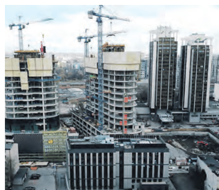
Budowa Global Office Park
