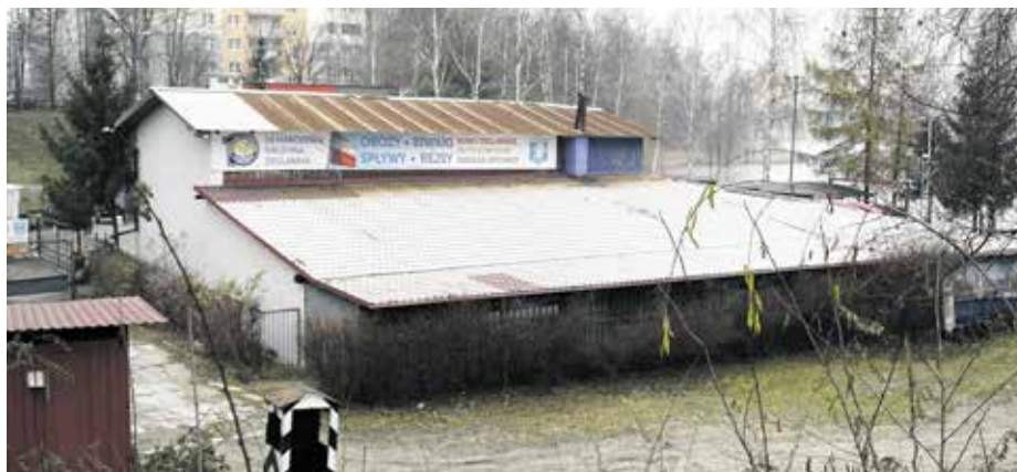
W miejsce starego obiektu powstanie nowoczesny budynek, który będzie służył mieszkańcom Katowic, m.in. harcerzom
