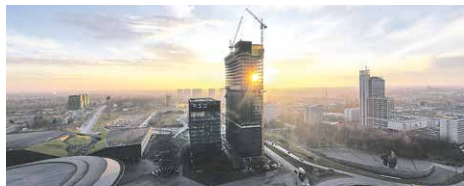
Budowa biurowca .KTW II w Katowicach
