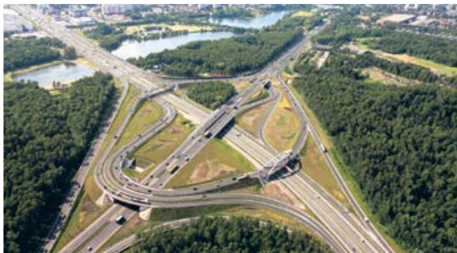
Węzeł Murckowski, czyli skrzyżowanie autostrady A4 i DK86
