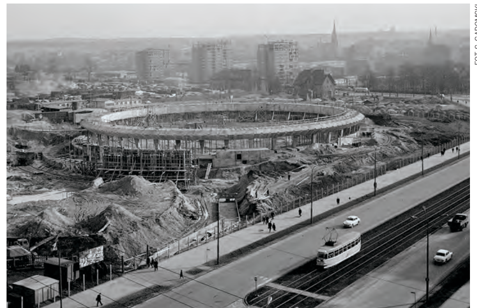
Budowa Spodka, lata 60. Jedno ze zdjęć prezentowanych na wystawie
