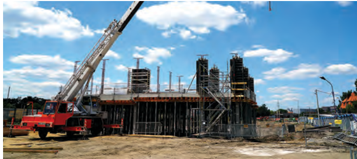
Węzeł przy ul. Sądowej
