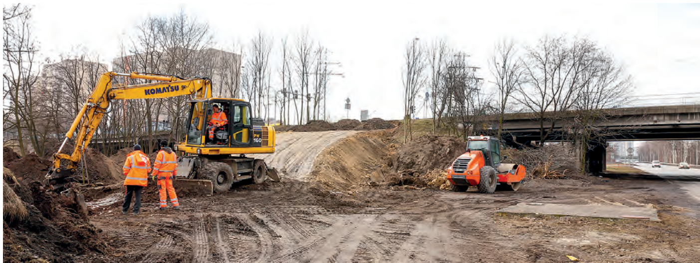
Budowa zjazdu dla rowerów łączącego ul. Bohaterów Monte Cassino z Bulwarami Rawy
