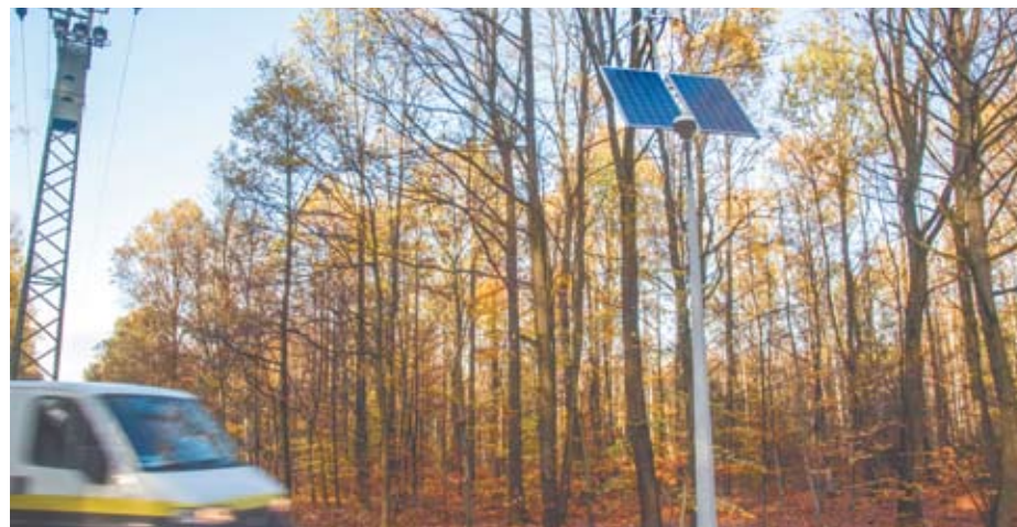
Nowoczesne latarnie wykorzystujące energię odnawialną stanęły w miejscach, gdzie nie ma możliwości tradycyjnego zasilania - na zdjęciu ul. Cegielnia w Murckach.
