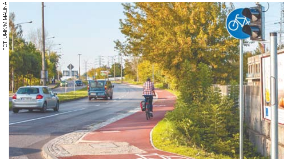
Nowo wybudowana ścieżka rowerowa na ul. Bohaterów Monte Cassino
