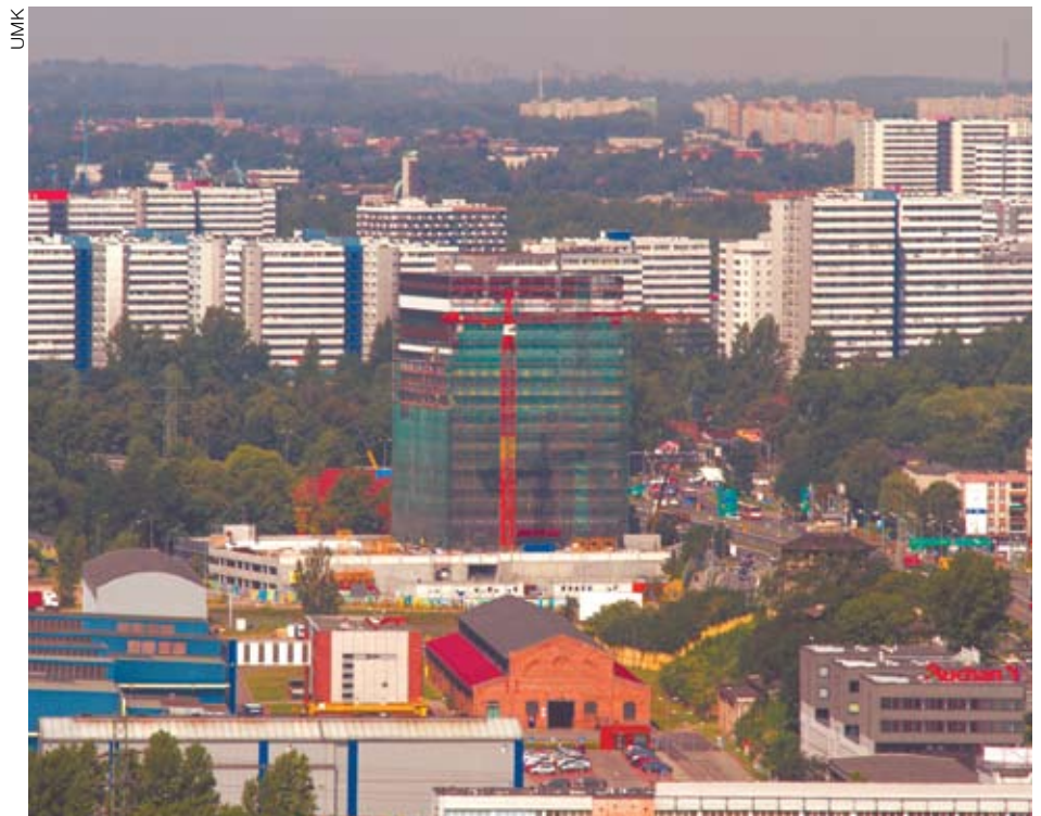
Inwestycja Skanska Property Poland przy ul. Chorzowskiej
