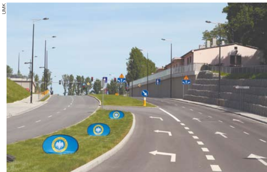
W ramach inwestycji zrealizowano 2,19 km nowych i przebudowanych dróg
