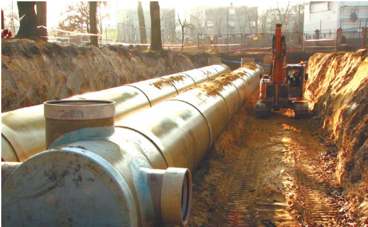
Montaż zbiornika retencyjnego, plac Fojkisa
