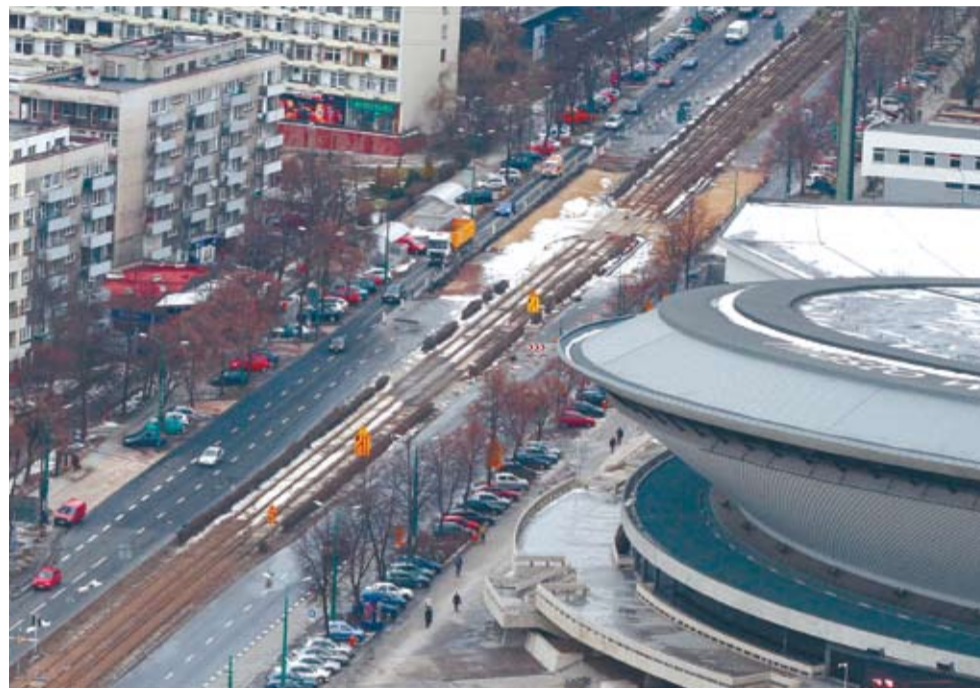
AL. KORFANTEGO: Czekają nas dalszy ciąg remontu torowisk
