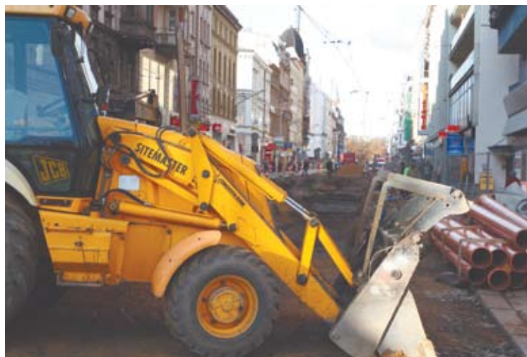
Przebudowa kanalizacji w ul. 3 Maja
