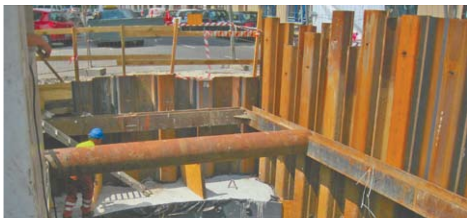
Wymiana sieci kanalizacyjnej w ul. Moniuszki
