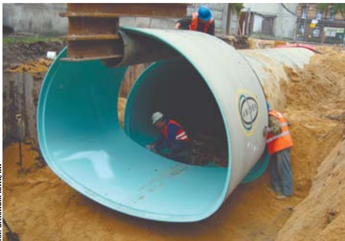
Budowa kolektora w ul. Katowickiej
