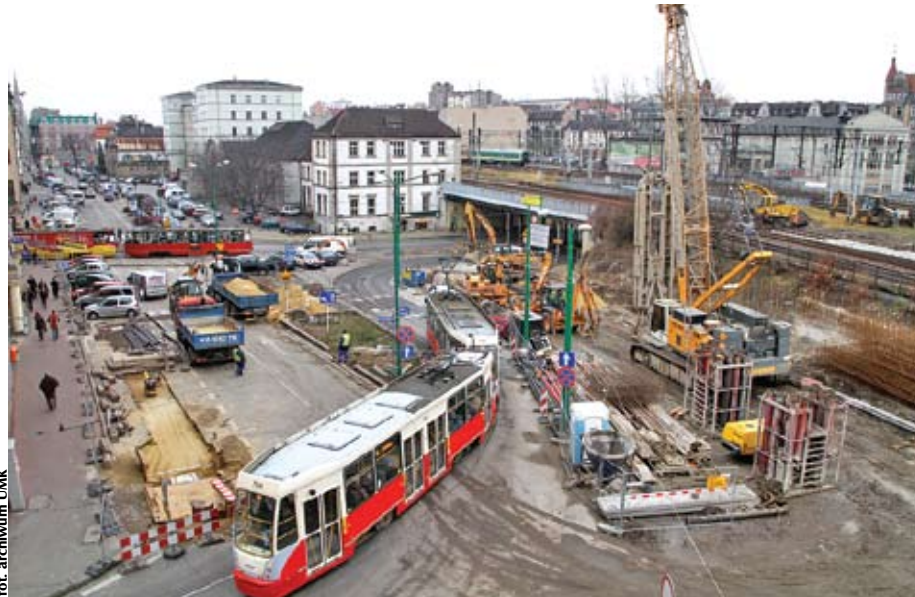
Konieczne będzie zsynchronizowanie przebudowy dworca PKP z modernizacją torowisk
