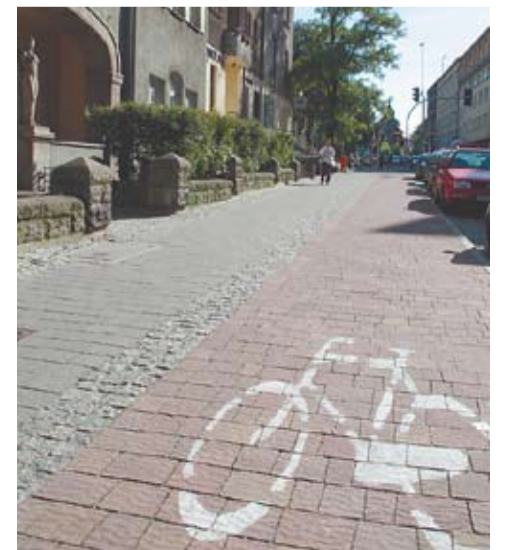
Fragment ścieżki rowerowej przy ulicy Wita Stwosza
