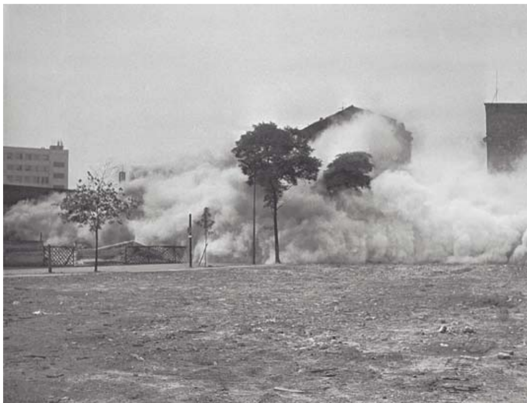
Na zdjęciu uchwyciony został moment uruchomienia ładunków wybuchowych w jednym z ostatnich budynków wyburzanych przy ul. Młyńskiej (od lewej – fragment budynku Poczty Polskiej, kopuła kościoła garnizonowego, fragment budynku przy ul. Słowackiego)
