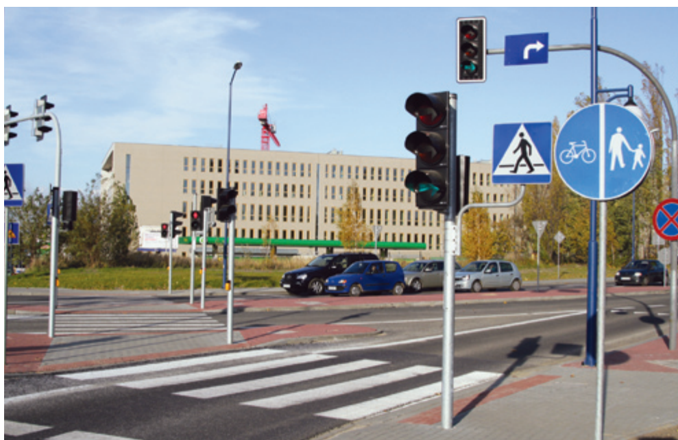
Zmodernizowane skrzyżowanie w okolicy nowego budynku sądu
